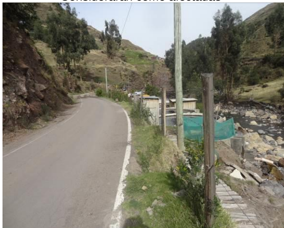
Estructuras aledañas a la vía que se Considerarán como afectadas
