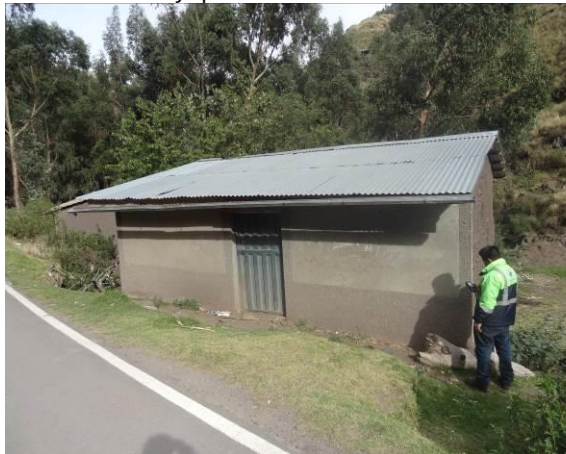
Afectación de vivienda aledaña a la vía y que será afectada
