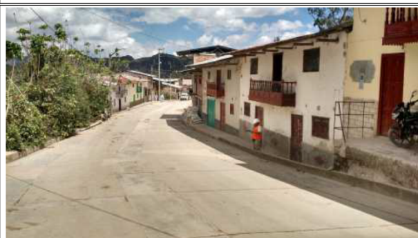
Vista de la vía alterna de para el acarreo de minerales de la UM. Cerro Corona a la UM. Tantahuatay
