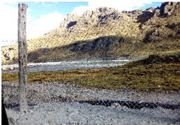
Tubería de evacuación de aguas de la relavera Andaychagua Alto.
