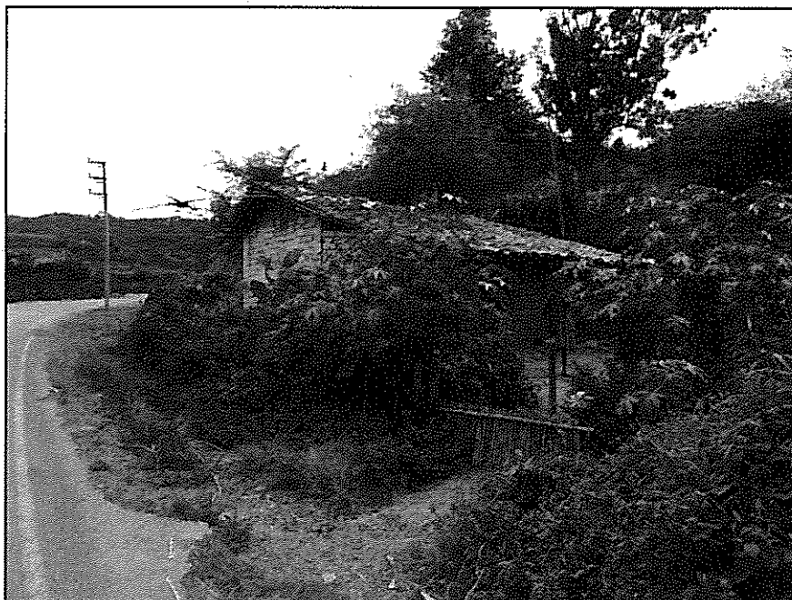
Vista de la Vivienda Afectada
