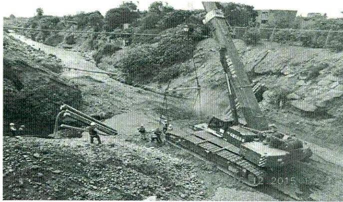
Instalación del bloque de concreto que contiene a las tuberías en el cruce.
