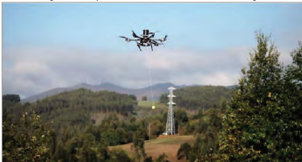
Figura N° 02 – Empleo de drones en las actividades de tendido de cable guía
