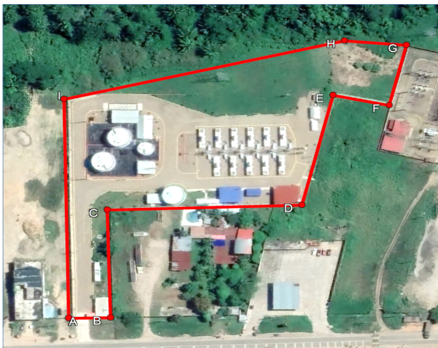
Central Térmica Reserva Fría - Puerto Maldonado
