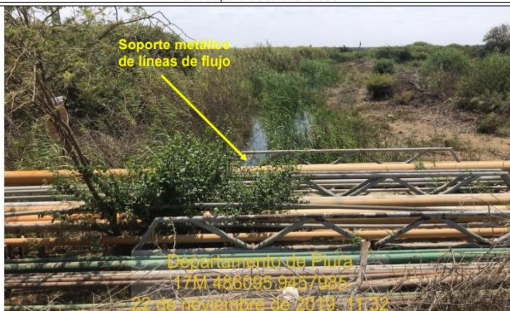
Fotografía N° 26: En el sector donde se ubicara la Troncal T8 se observa la presencia de soporte metálico de líneas de flujo
