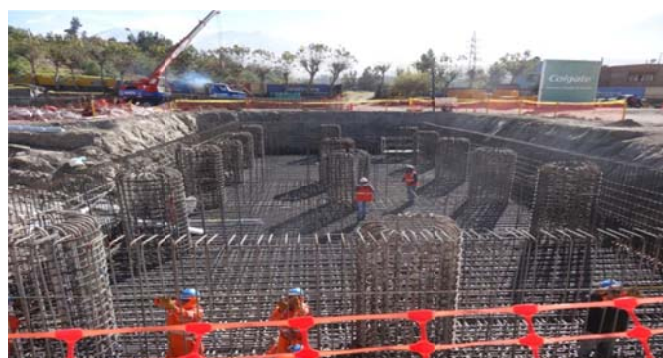
COLOCACIÓN DE ACERO DE REFUERZO EN CABEZAL DE PILOTES
