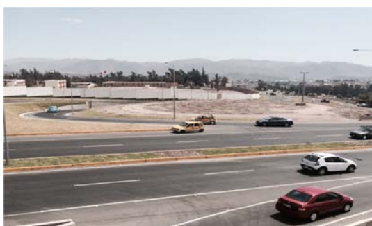
PUENTE CHILINA Y ACCESOS EN OPERACIÓN
