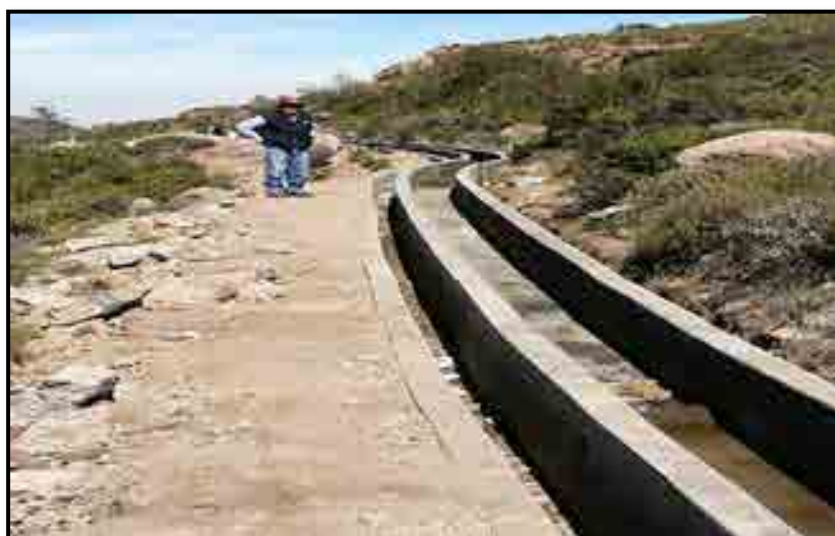
INFRAESTRUCTURA DE RIEGO DE LA IRRIGACION HUANZOCOCHA
