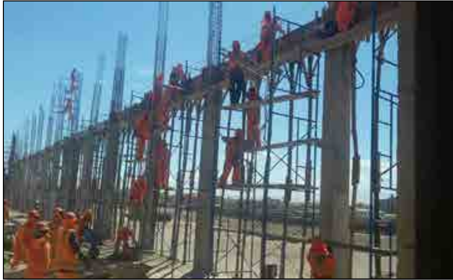
TERMINAL TERRESTRE DE MAJES PROVINCIA DE CAYLLOMA
