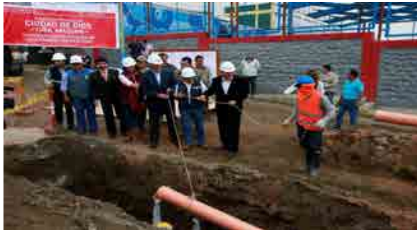
REDES DE ALCANTARILLADO CIUDAD DE DIOS – YURA
