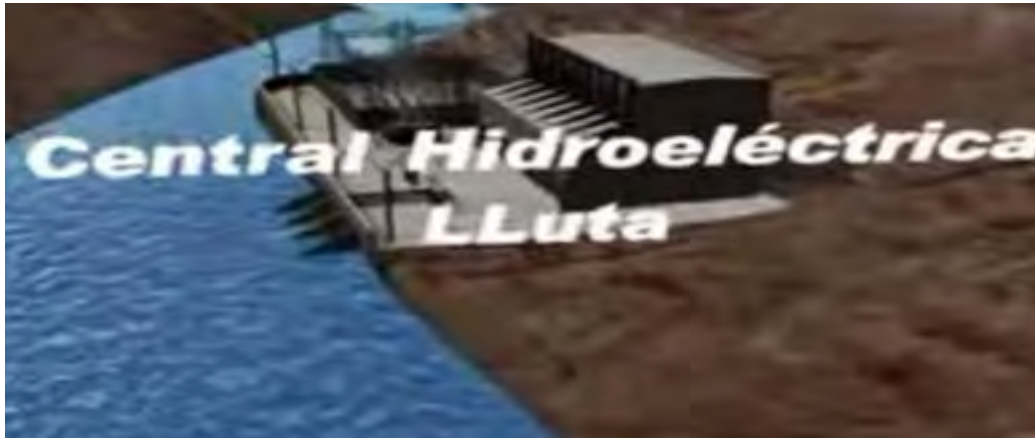
Central Hidroeléctrica Lluta Fuente: Proinversión
