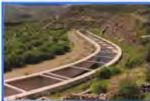
Canal de Aducción
