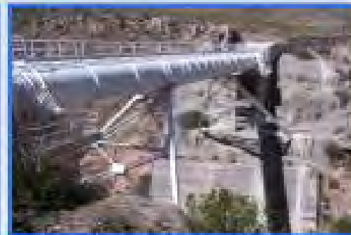
Acueducto de acero en Quebrada Matadero (80 m)
