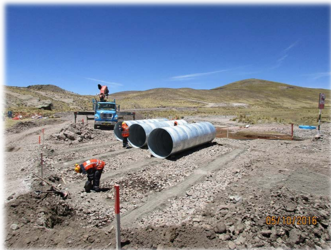
COLOCACIÓN ALCANTARILLAS
