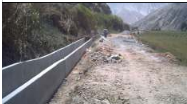
MEJORAMIENTO DE LA BOCATOMA SISTEMA DE RIEGO Y REHABILITACION DE DEFENSA RIBEREÑA LA PASCANA II ETAPA
