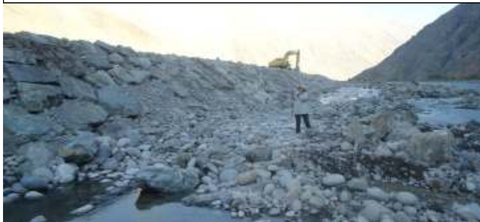
CONSTRUCCION DE DEFENSA RIBEREÑA SECTOR SANTA RITA II ETAPA
