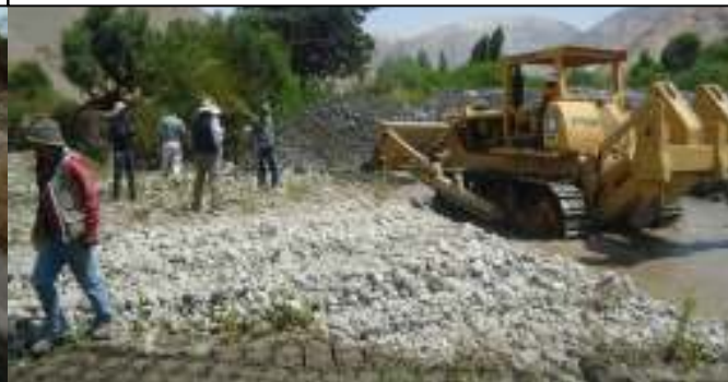
INSTALACIÓN DE DEFENSA RIBEREÑA EN EL RIO TAMBO SECTOR HUAYRONDO
