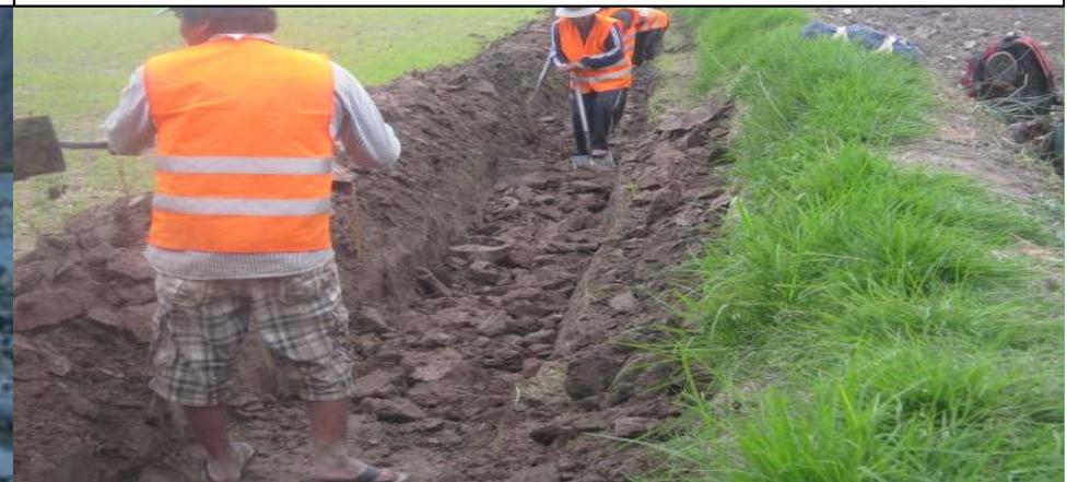
MEJORAMIENTO DEL CANAL EL BRAZO CAMANA – III ETAPA
