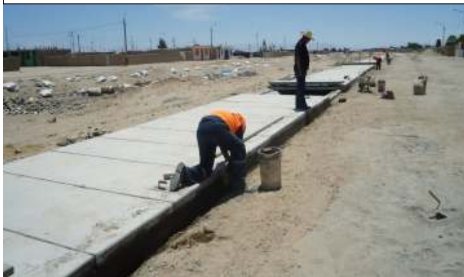
MEJORAMIENTO CANAL MADRE SANTA RITA DE SIGUAS II ETAPA
