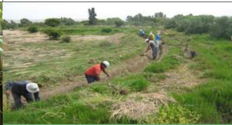
CONSTRUCCION DE CANAL MUNCHUER SANTA ISABEL BAJO
