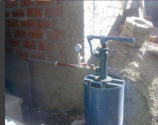
PRUEBA HIDRAULICA
