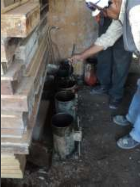
Probetas para pruebas de resistencia del concreto
