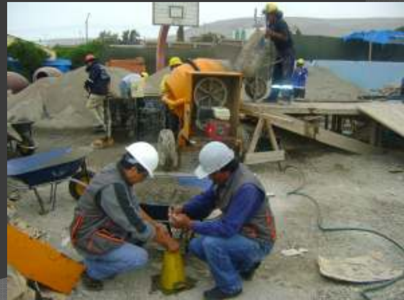
Elaboracion del slump para control de cantidad de agua en concreto
