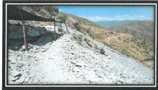
Labor N°8: inestabilidad de talud por la inadecuada disposición de material de rechazo.
