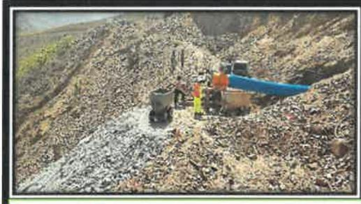
Labor N° 7. Inadecuada disposición de material de rechazo inestabilidad de talud.
