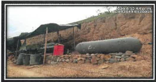
Labor N°2. Tanques de combustible sin sistemas de contención.
