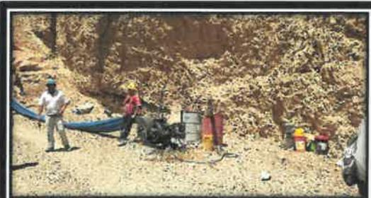
Labor N° 8. Derrame de hidrocarburos por el inadecuado almacenamiento de insumos.
