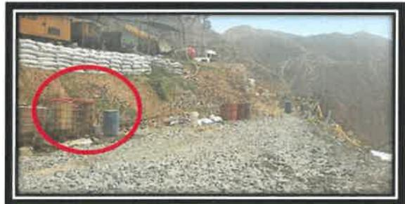
Labor Virgen del Rosario. Almacenamiento de combustible sin sistemas de contención afectando el componente
