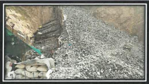
Labor N° 11. Infraestructura deficiente para el almacenamiento de material de desmonte
