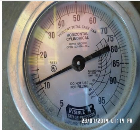
Medición del Stock del tanque 01 para GLP Vehicular, 11.8 % = 377.60 galones.
