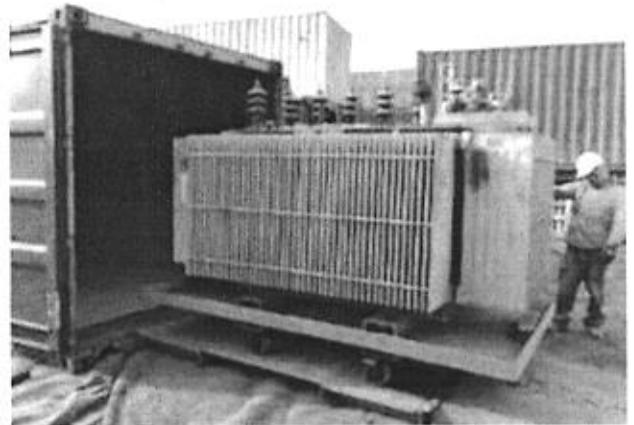
**Movimiento interno de equipos con PCB**
