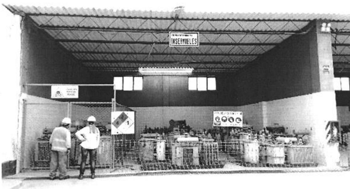
**Figura N° 23: Área de almacenamiento de PCB dentro del almacén de residuos peligrosos**
