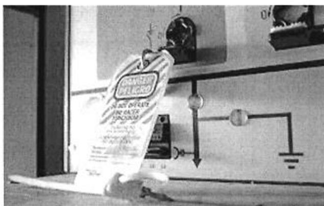
Figura N° 15: Bloqueo y etiquetado de un interruptor
