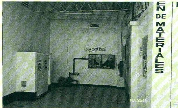
Fotografía N°2 Recinto de la PAA Chiclayo donde se observa una bomba comercial de agua (no listada) que está fuera de servicio y gabinete de manguera que según letrero pertenece al Sistema contra incendio.
