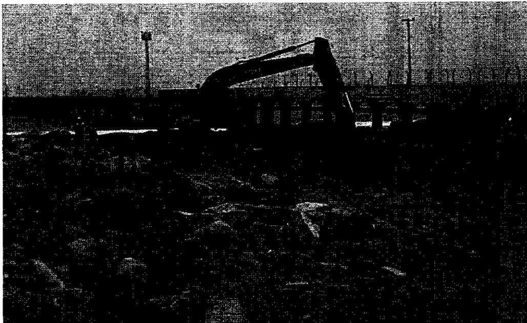
Foto N° 2: Trabajos de enrocado de defensa, Corte de material para conformación de uña.
