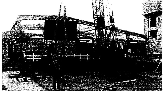
Fotos 01 y 02: Desmontaje de productor de hielo (al 50%) e izaje a zona de almacenamiento.
