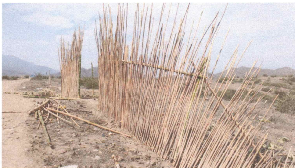
Imagen 04. Vista general, afectación del Sitio Arqueológico, excavación y colocación de cercos.
