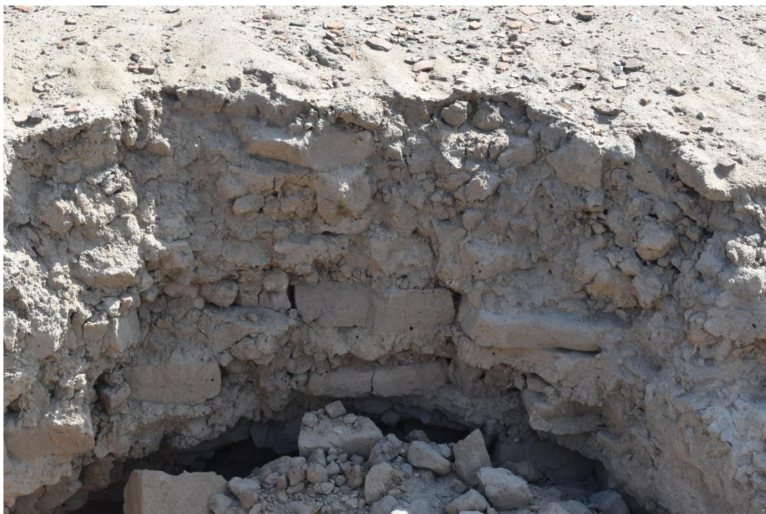
Fig. 18. Vista en detalle de arquitectura prehispánica, nótese los adobes que conforman la estructura arqueológica. Esta fotografía fue tomada como referencia para dejar constancia del estado actual del sitio arqueológico "Huaca de La Rosa", esto con fecha 05 de Marzo del 2020.
