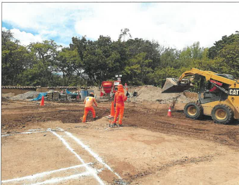
IMAG. N°17.- Se observa el aplanamiento del terreno para la habilitación de módulos según la zonificación.
