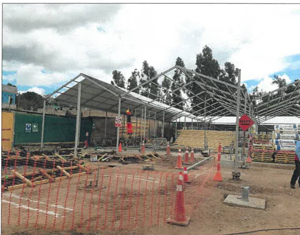
IMAG. N°15.- Proceso de edificación temporal de módulos, se observa personal limitado en labores propias de la obra.
