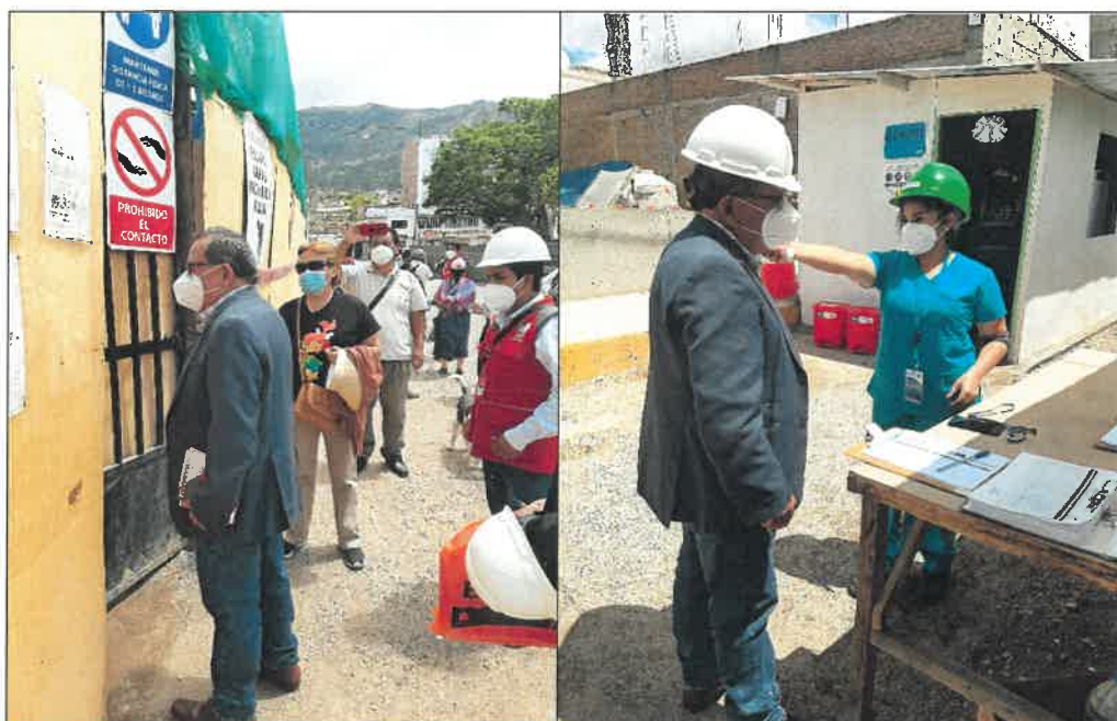
IMAG. N°05.- Visita a Obra con fines de fiscalización integrada por la Comisión de Infraestructura y Proyectos de Inversión Pública y la inclusión del C.R. Oscar Ore curo y la C.R. Cleofe Pineda Gamboa.
