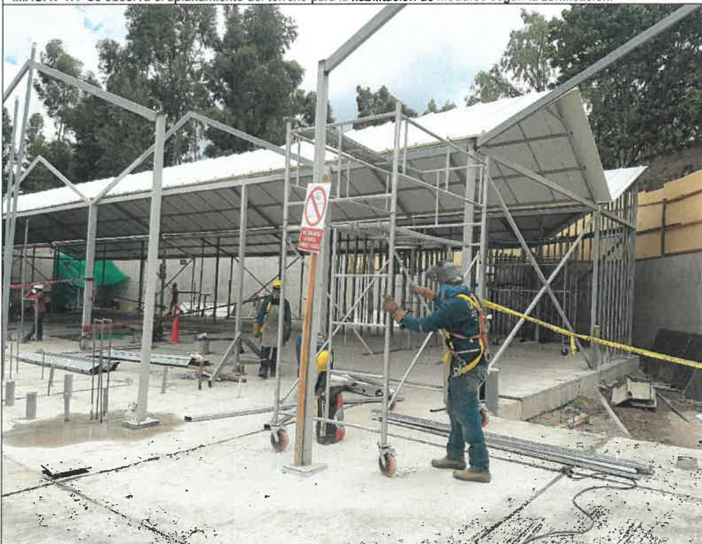
IMAG. N°18.- Se observa el ensamblaje de las estructuras ligeras y cobertura de paneles termoaislantes.
