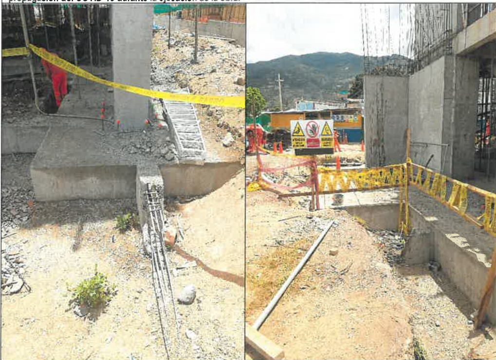
IMAG. N°08.- Se evidencia la viga de cimentación en condiciones de empalme cuando se realice la intervención de la estructura complementaria.
