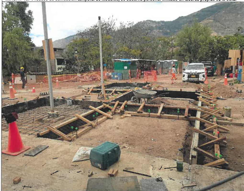
IMAG. N°16.- Habilitación de áreas destinadas a la construcción de módulos del Hospital de Contingencia.
