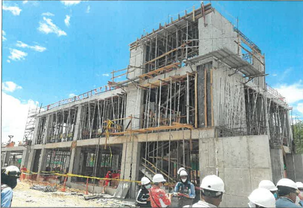
IMAG. N°12.- Panorámico del avance de la estructura en ejecución
