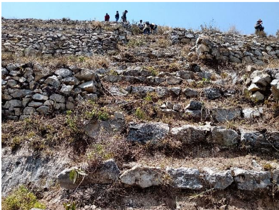
Foto N° 006; Vista panorámica del lado sur-este, en la cual podemos observar los andenes que presenta de mampostería simple, construido con piedras de campo unido con argamasa de barro. Los cuales están asociado a escalinatas de acceso.
