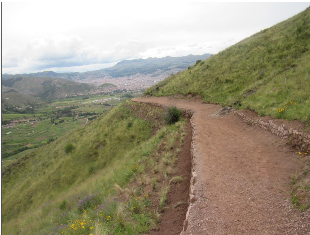
Vista panorámica del trazo del camino de tipo plataforma corte talud, con muros de sostenimiento.
