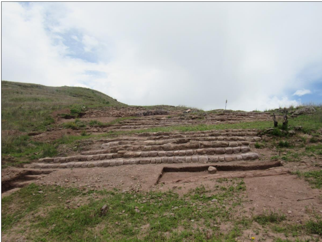
Escalinatas, construido con elementos líticos de tipo arenisca unidos con mortero de arcilla, se evidencia en el sector de Muyu Mocco.
