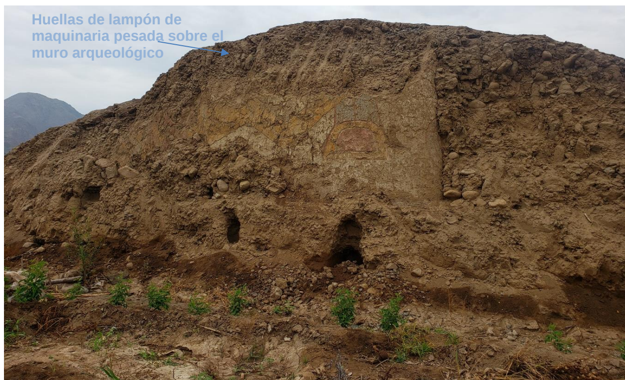
Imagen 10. Vista de Sur a Norte, nótese las huellas de las uñas del cucharón de la maquinaria pesada que han alterado el muro arqueológico decorado con frisos policromo e incisiones. En la parte inferior se observa las filtraciones de agua que están socavando el cimiento de este muro arqueológico.
