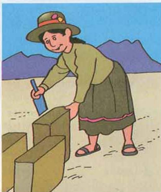
Se recomienda utilizar los adobes en los muros 3 semanas después de haberse elaborado para evitar rajaduras, después de las cuales los adobes ya pueden ser usados para levantar los muros.
