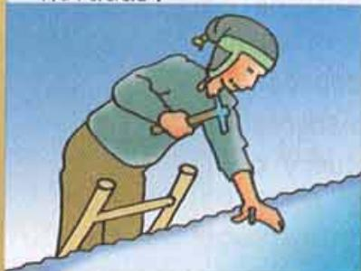
Si se observa que algún clavo de la calamina se salió, se debe asegurar de inmediato, para evitar que el viento dañe la calamina.
