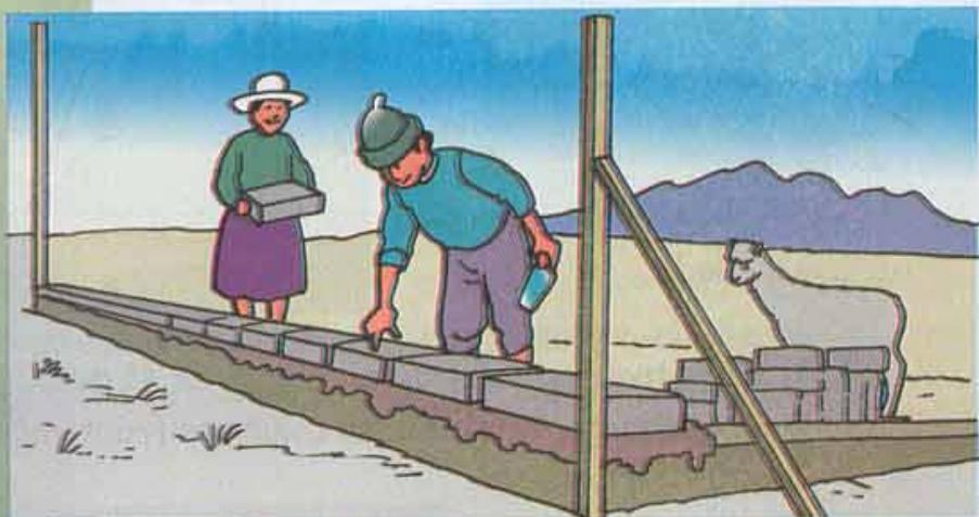
Se recomienda utilizar el mortero de 2.5 cm entre junta y separación de adobes, se debe amarrar un cordel para la alineación del muro.
