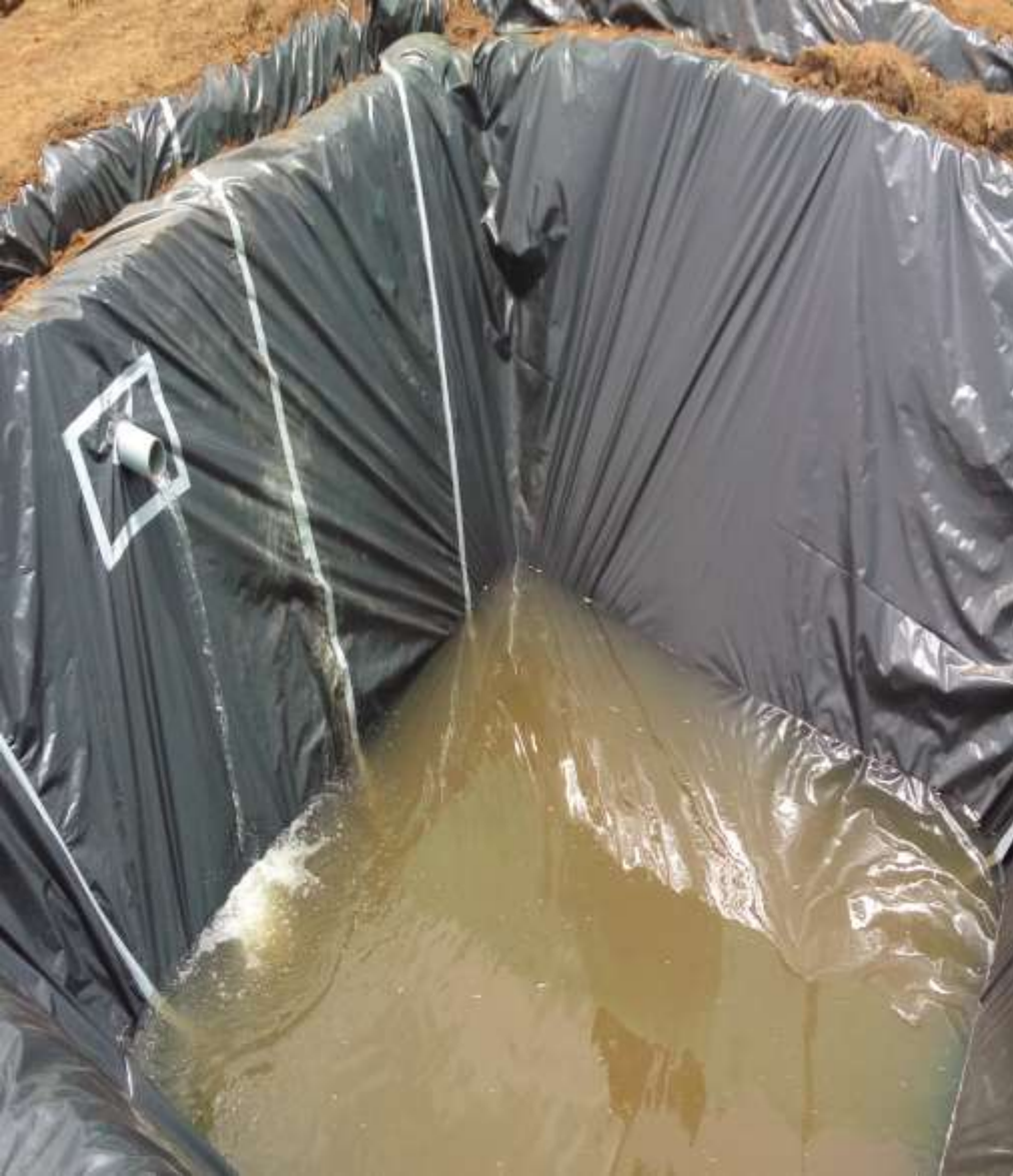
RESERVORIO DE CAPACIDAD DE 50 M3
