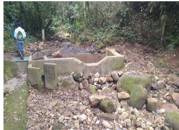
**Foto No. 01:** Vista de la captación en la Qda. en épocas de verano, toda el Agua de la quebrada ingresa al sistema.
