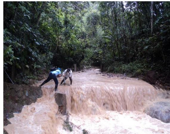
**Foto No. 02:** En noviembre del 2014 las aguas de la Qda. inundaron la Captación, tal como se aprecia en la vista fotográfica, los operarios cerrando la Compuerta de captación.
