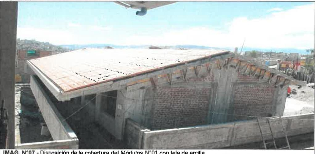
IMAG. N°07.- Disposición de la cobertura del Módulos N°01 con teja de arcilla.
