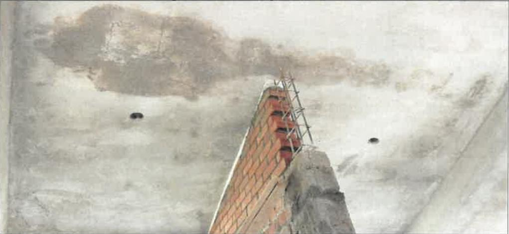
IMAG. N°04.- Se observa humedecimiento en diferentes sectores del área interior de la losa aligerada.
