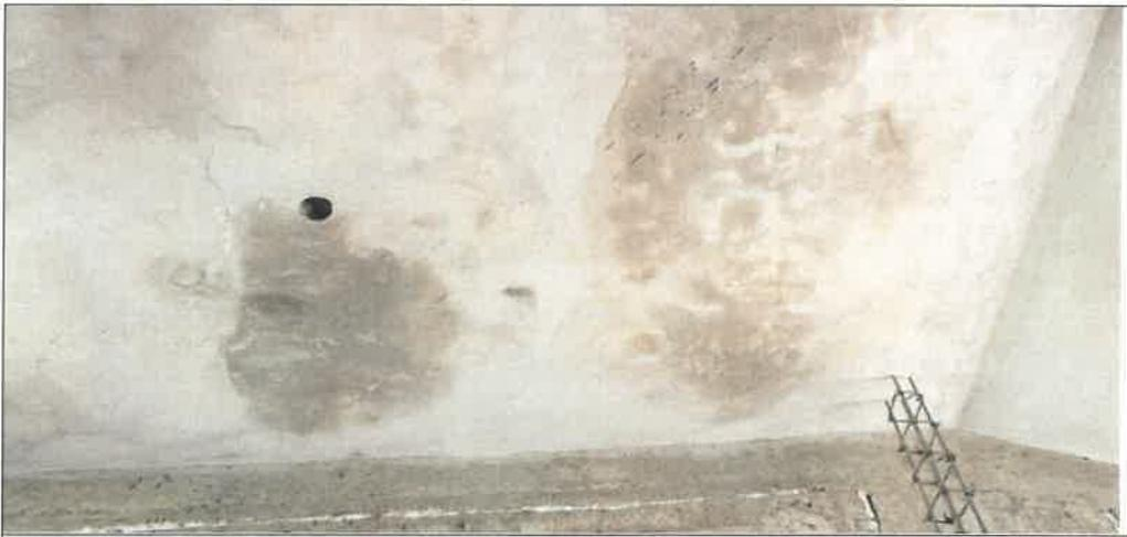
IMAG. N°05.- Se observa humedecimiento en diferentes sectores del área interior de la losa aligerada.
