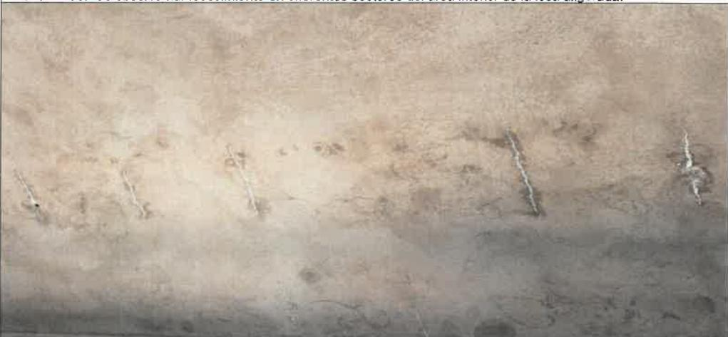
IMAG. N°06.- Se observa fisuras en la parte interior de la losa originado por cambios sucesivos de temperatura o humedad.
