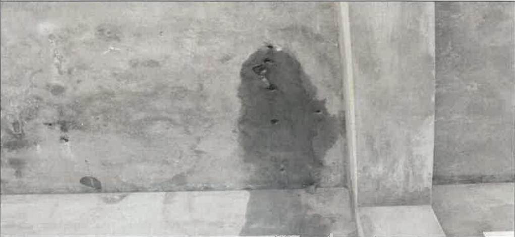
IMAG. N°03.- Se observa filtración de agua de lluvia en losa aligerada inclinada en Módulo N°01.
