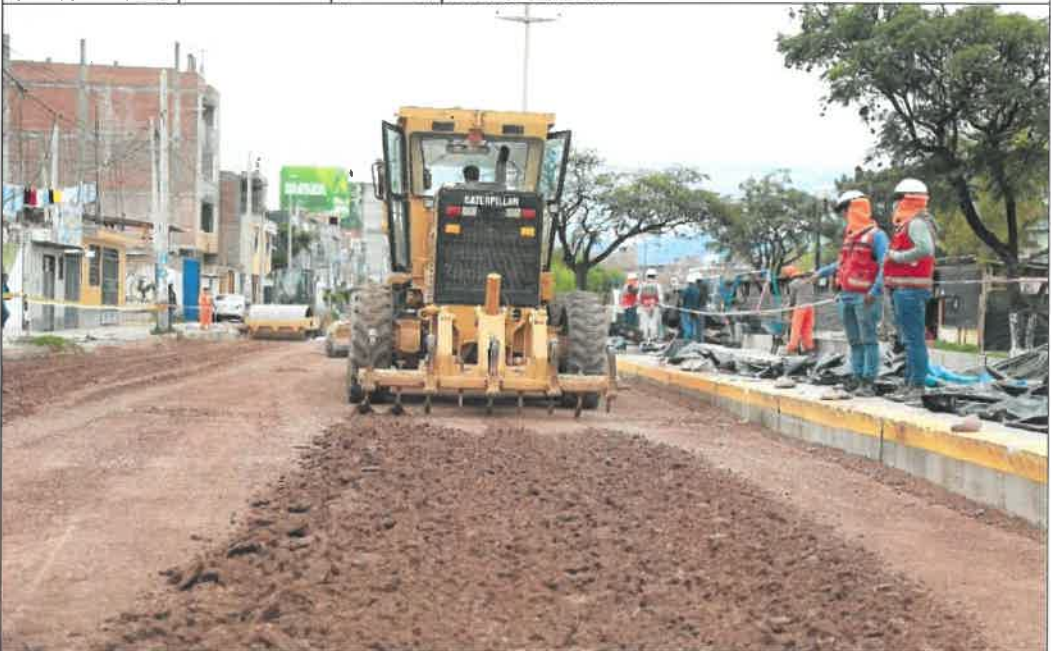
IMAG. N°14.- Maquinaria del GRA puesto a disposición de la obra.
