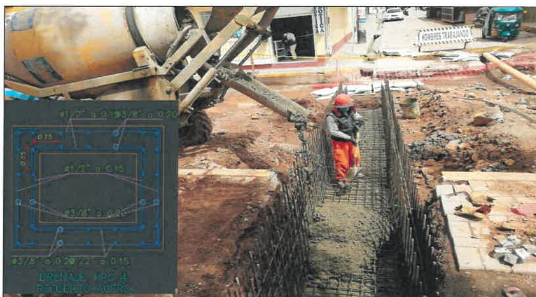
IMAG. N°15.- Disposición de aceros en obra.
