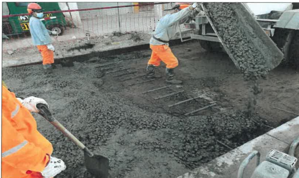
IMAG. N°17.- Disposición de aceros en obra.
