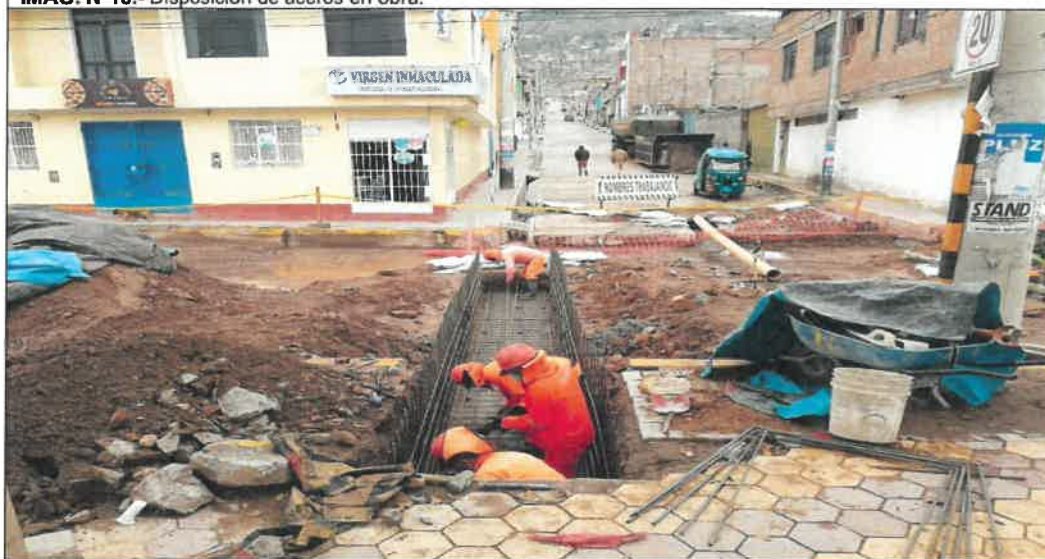
IMAG. N°16.- Disposición de aceros en obra.
