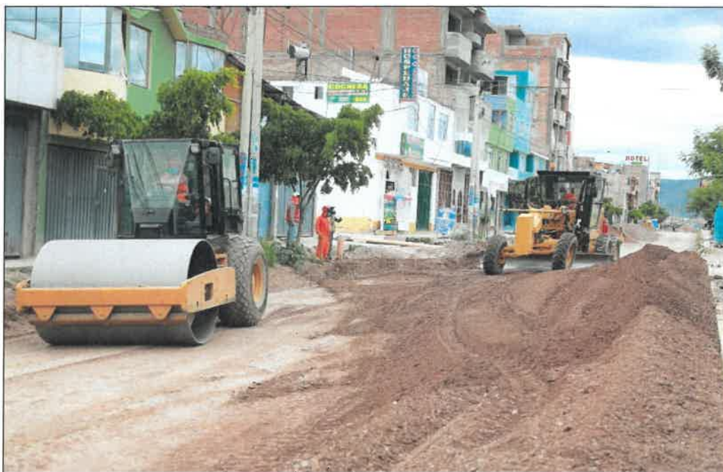
IMAG. N°12.- Maquinaria del GRA puesto a disposición de la obra.
