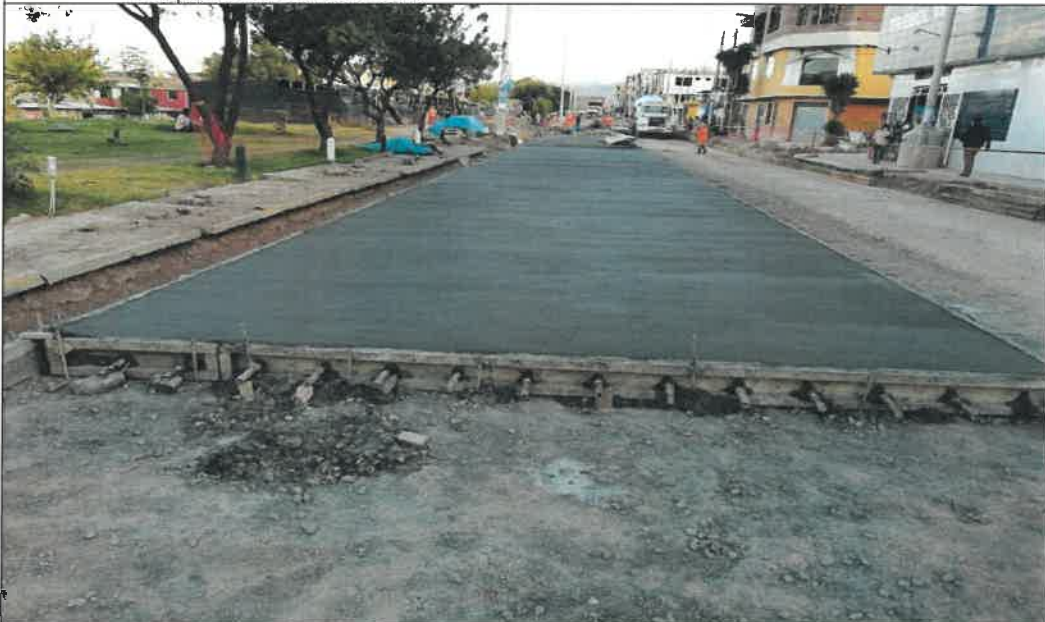
IMAG. N°18.- Disposición de aceros en obra.
