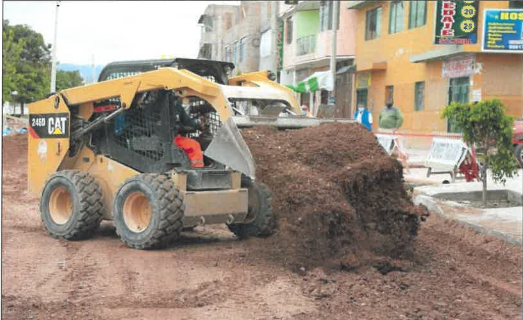
IMAG. N°13.- Maquinaria del GRA puesto a disposición de la obra.
