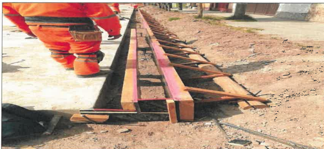
IMAG. N°19.- Disposición de madera para encofrado de sardinel.
