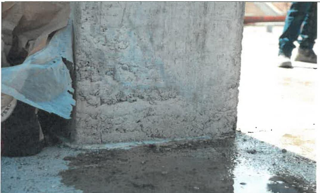
IMAG. N°06.- Se evidencia presencia de cangrejas en columna (segundo nivel de la edificación)
