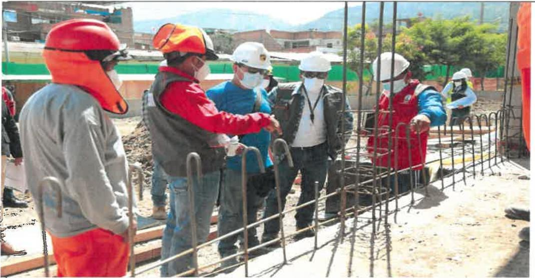
IMAG. N°10.- Se observa el anclaje de aceros en muro previamente vaciado.
