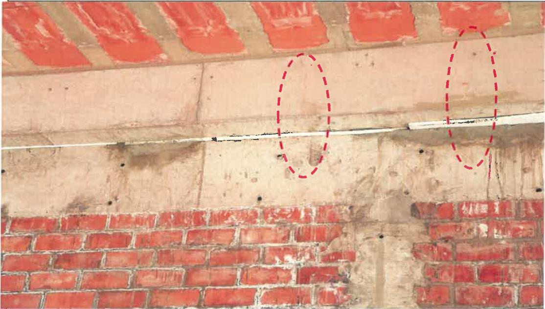
IMAG. N°03.- Se observa fisuras en diferentes vigas.
