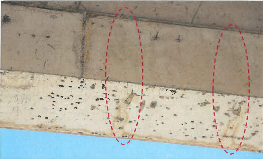
IMAG. N°02.- Se observa fisuras en diferentes vigas.
