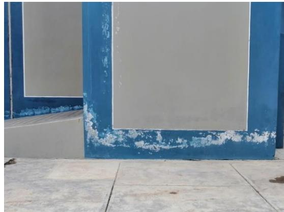
Humedad no solamente en muros superiores igualmente humedad en parte baja, se aprecia, deficiencias en zona de canaletas y en zona bajas por mala instalación de coberturas y/o aleros cortos, no adecuados para zonas de sierra.
