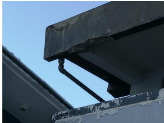
Filtraciones y desprendimiento de tarrajeo de zonas de cunetas de techo, en ambientes de primaria.( módulos de 2 pisos)
