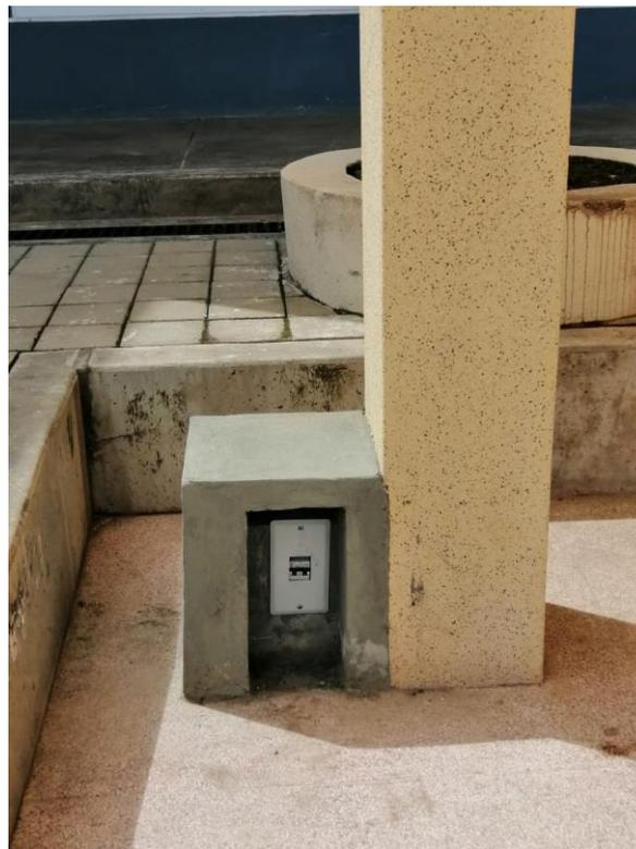
Parte eléctrica expuesta, en zona baja falta colocar un protector a la caja de llave térmica ubicado debajo de una columna y esta al alcance de cualquier alumno, que pueda manipularlo y accidentarse, falta proteger esta caja de llave térmica.
