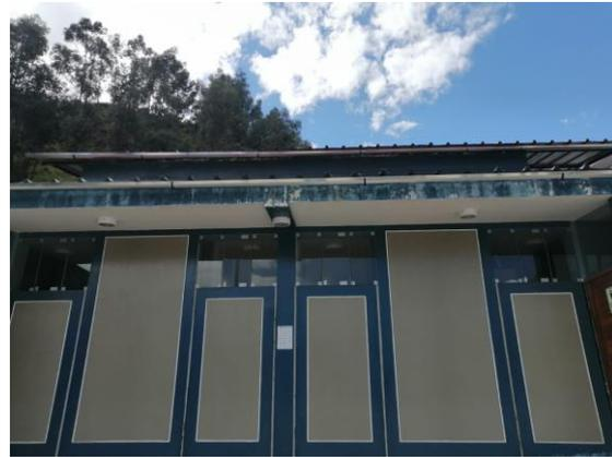
Humedad en paredes cercanas al techado, no solo partes verticales por salpicadura, sino también en la parte baja cerca a las canaletas, no solo habría que revisar el techado con planchas de calaminon, sino aparte todas las canaletas porque se ve que por ahí filtran o salpican el agua en épocas de lluvias.
