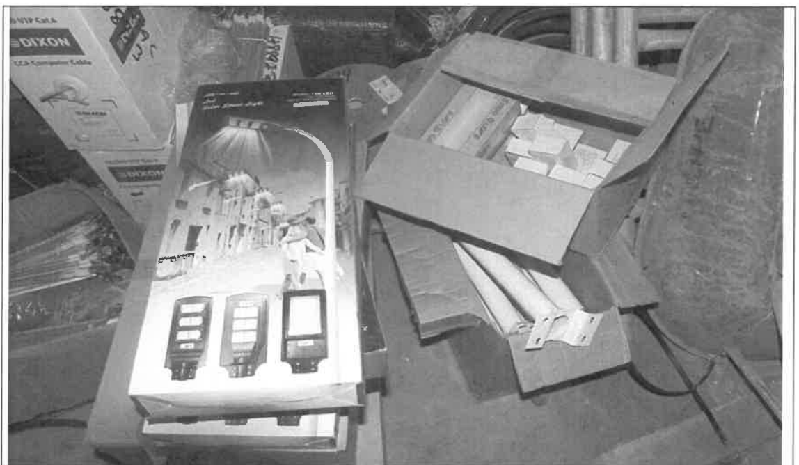
IMAG. N°04.- Se evidencia la falta de materiales eléctricos
