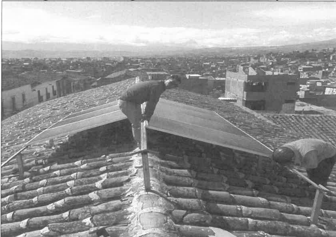
IMAG. N°01.- Vista de la instalación de paneles solares.
