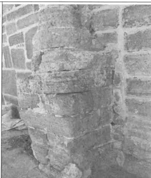
IMAG. N°10.- Los capiteles, fueron dejados a medio retiro de la capa pictórica, lo cual va generar deterioro del material, asimismo se va perdiendo la cohesión de las partículas del material.
