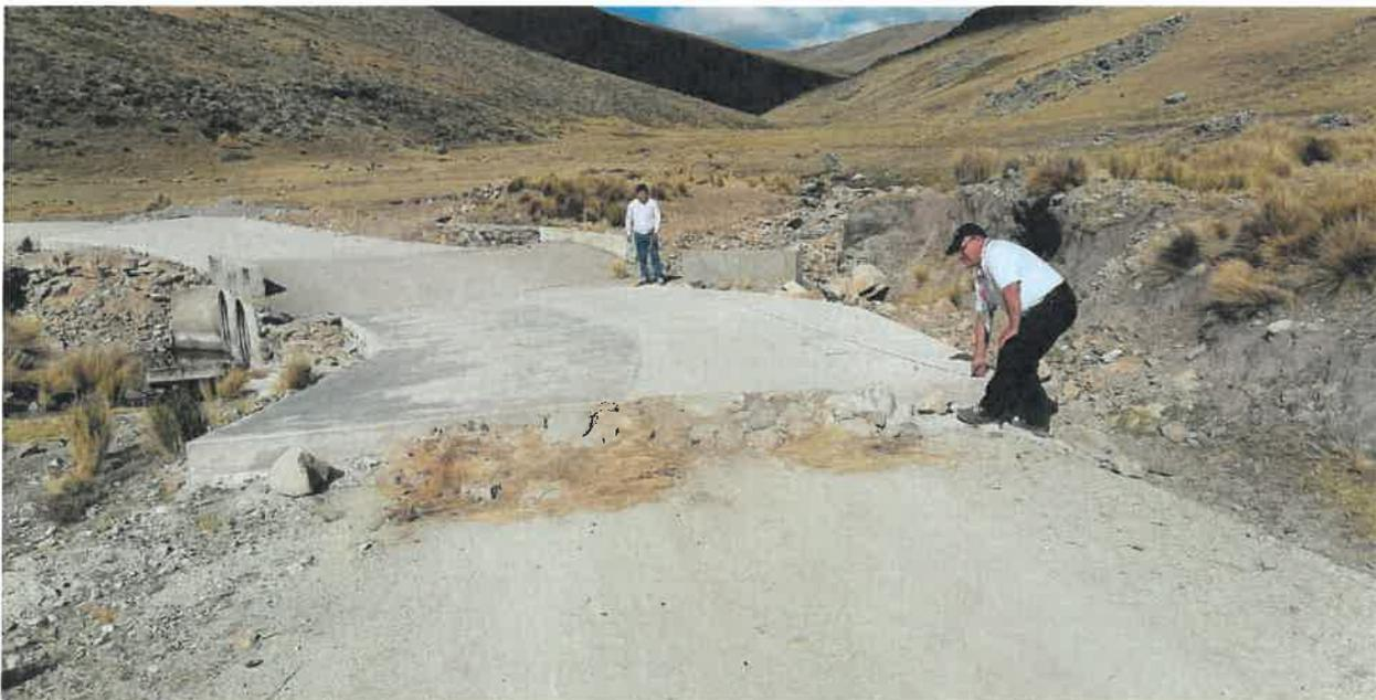
**BADEN Y ALCANTILLA KM 28+950 MEJORADOS CON EL VACIADO DE CONCRETO A AMBAS CALZADAS Y MURO DE CONCRETO DE CONTENCIÓN**
