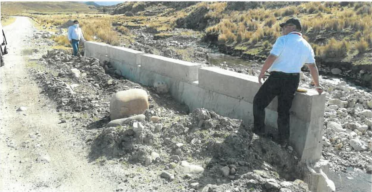
CONSTRUCCIÓN DE MUROS DE CONTENCIÓN DEL RIACHUELO PILLPIHUAYCCO DE LONGITUD DE 10.20M, ESPESOR SUPERIOR 0.40 M, CON ANCHO DE BASE 0.70M ALTURA 1.50M KM EN EL KM 23+500
