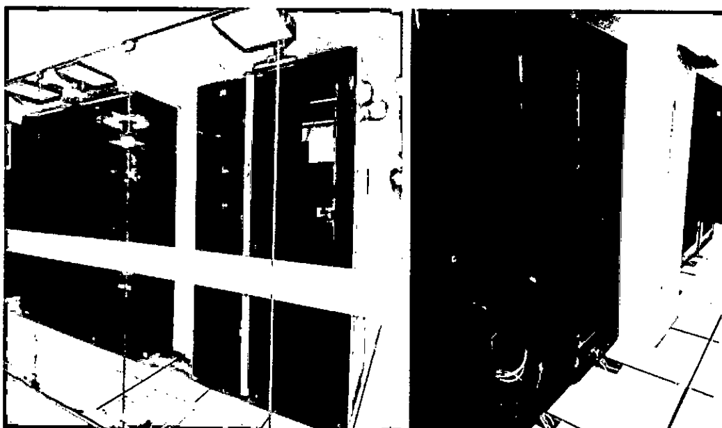
Figura N° 06: Centro de Datos de la Municipalidad Provincial de Piura
