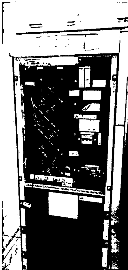
Figura N° 07: UPS Eaton modelo 9355 de 20 KVA
