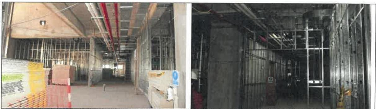
IMG. 04.- DISPOSICIÓN DE PARANTES Y PLANCHAS METÁLICAS, TABIQUERÍA SECO DE FIBROCEMENTO Y PLACA DE YESO RH.
