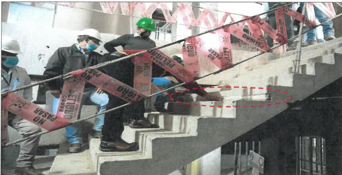
IMG. 06.- SEPARACIÓN EN UNO DE LOS PASOS QUE PERMITIRÍA EL MOVIMIENTO SÍSMICO EN LA ESTRUCTURA
