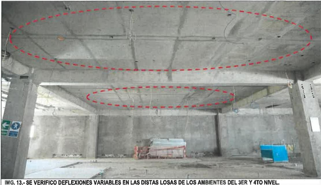
IMG. 13.- SE VERIFICO DEFLEXIONES VARIABLES EN LAS DISTAS LOSAS DE LOS AMBIENTES DEL 3ER Y 4TO NIVEL.
