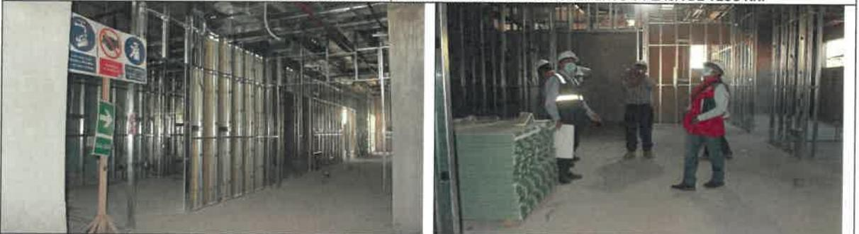
IMG. 05.- DISPOSICIÓN DE PARANTES Y PLANCHAS METÁLICAS, TABIQUERÍA SECO DE FIBROCEMENTO Y PLACA DE YESO RH.
