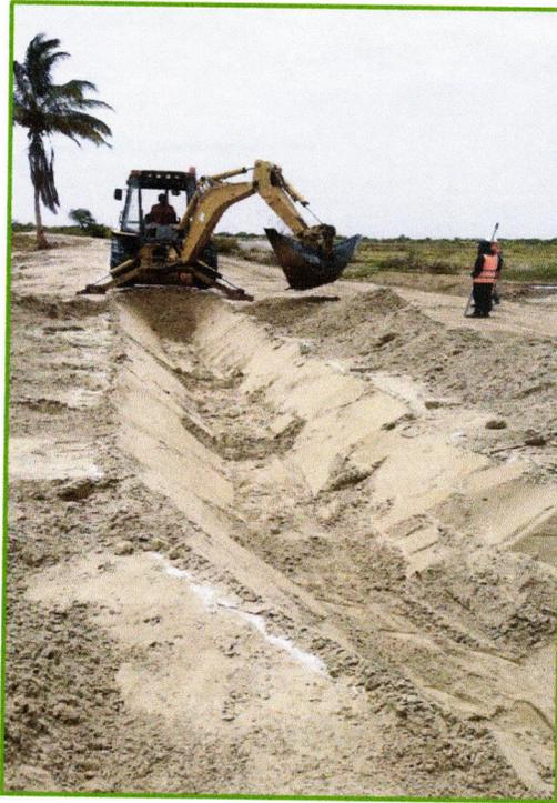
**VISTA 07:** Excavación de caja de canal en material de préstamo
