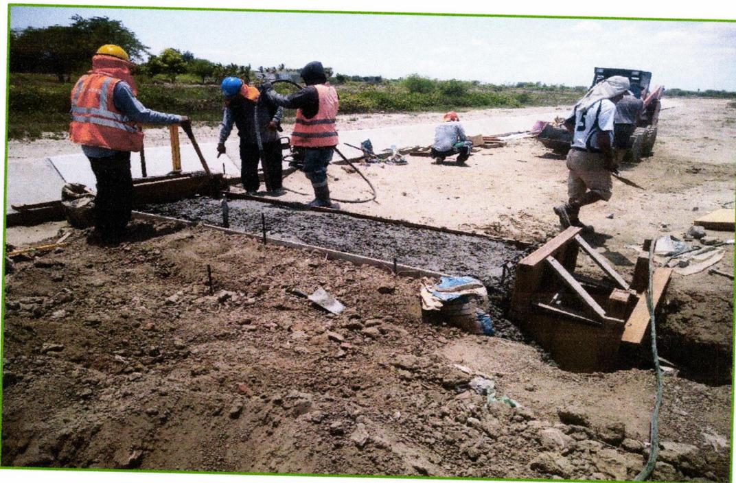
**VISTA 16:** vaciado de concreto en toma lateral
