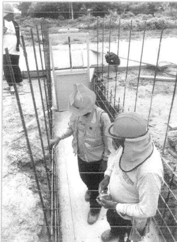
VISTA 02: Colocación de compuerta en toma lateral derecha
