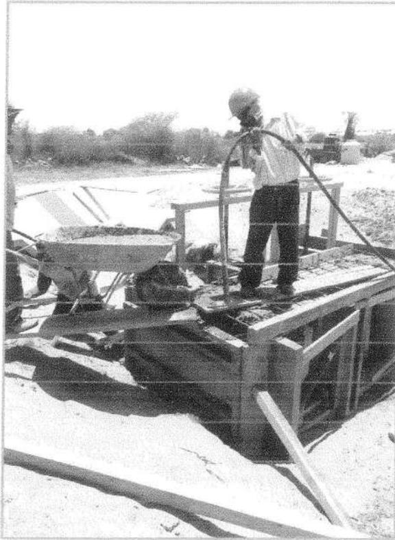
VISTA 17: vaciado de concreto en retención
