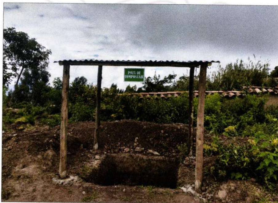
FOTO 02: Construcción de fosa de compostaje en el Reservorio Curuchi.
