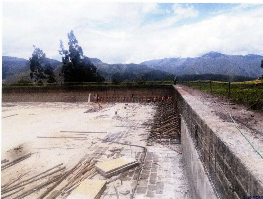
FOTO 08: SUPERVISION DE ENCOFRADO Y APUNTALAMIENTO DE PARED DE RESERVOIRIO
