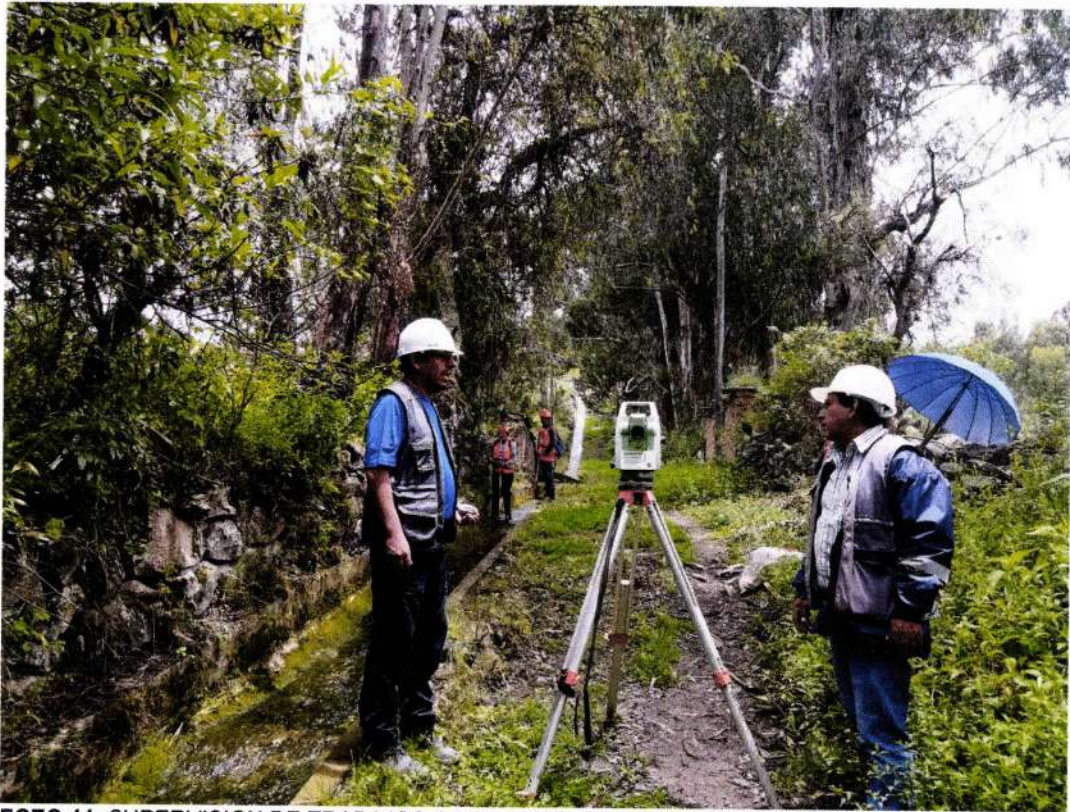
FOTO 11: SUPERVISION DE TRABAJOS A LO LARGO DEL CANAL Y SUS DERIVACIONES
