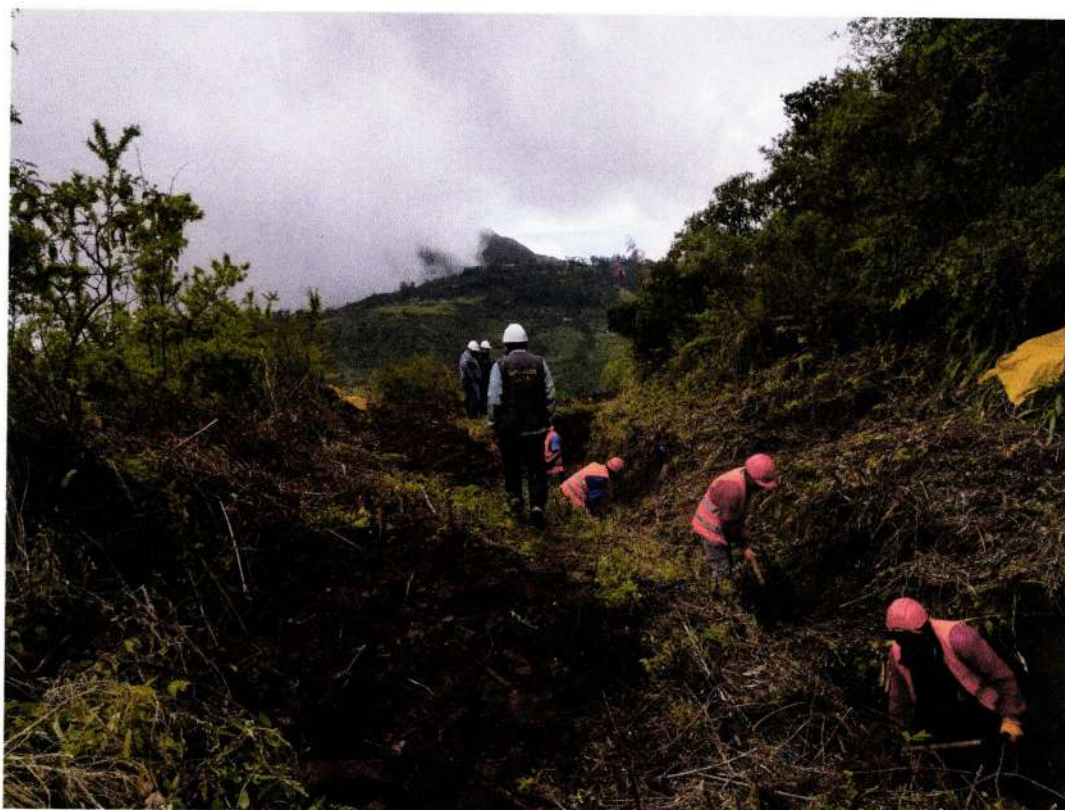
FOTO 06: SUPERVISION DE LIMPIEZA DE CANAL EN LA PROGRESIVA 9+700KM
