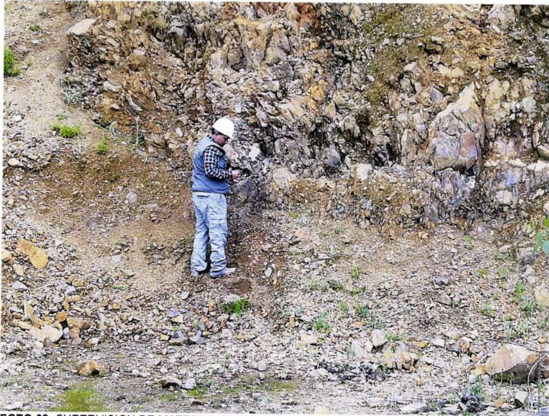
FOTO 09: SUPERVISION DE MATERIAL GEOLOGICO EN CAUSANTE DE ASENTAMIENTO
