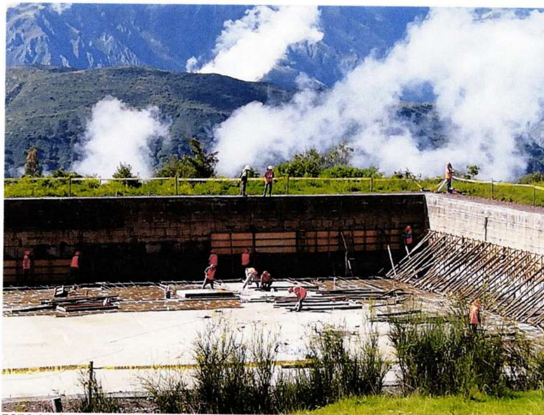
FOTO 04: SUPERVISION DE ENCOFRADO DE PARED DE RESERVORIO
