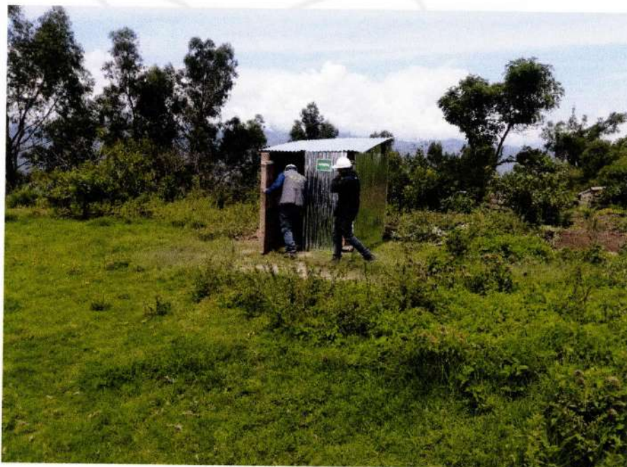
FOTO 04: Construcción de Letrinas en el Proyecto
