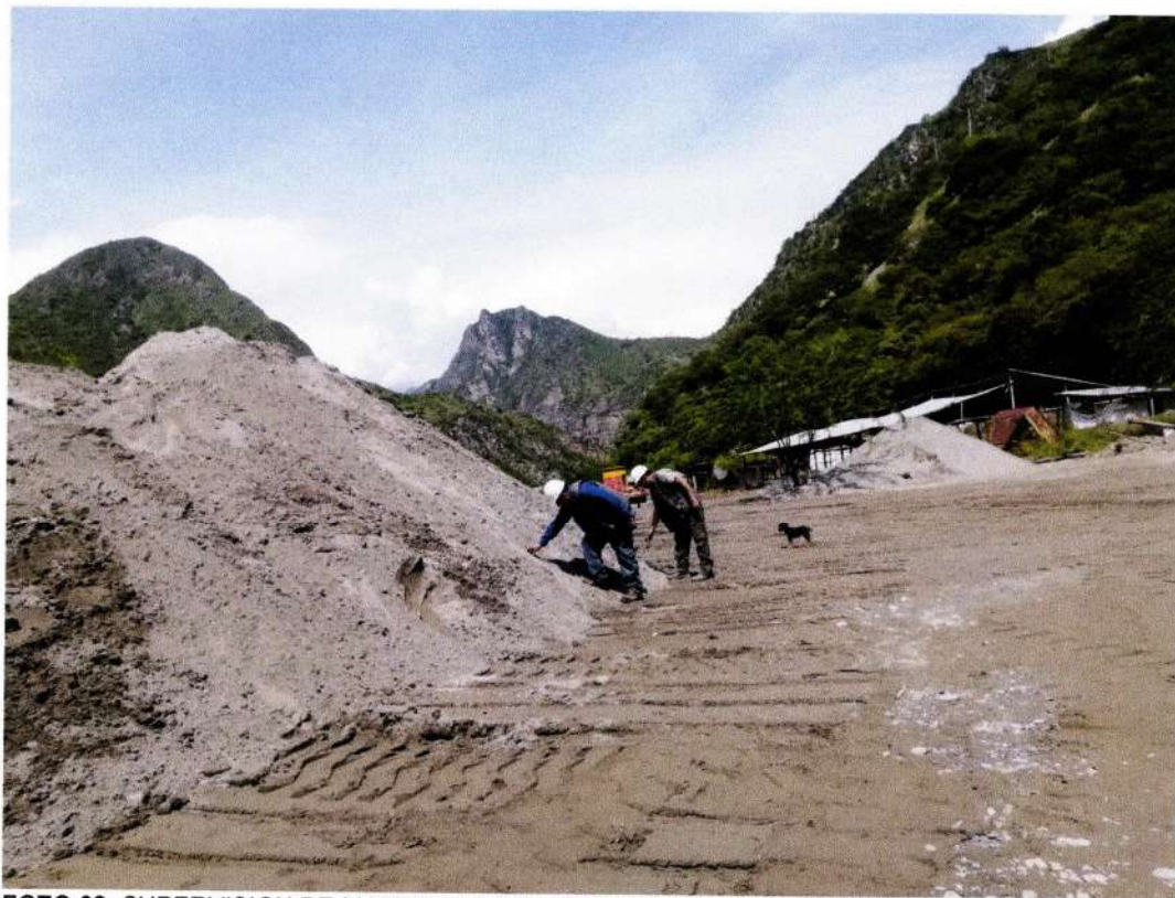
FOTO 03: SUPERVISION DE MATERIAL ARENA FINA CANTERA DE CUNYAC
