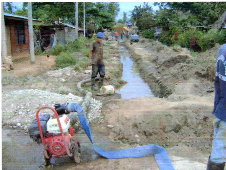
BOMBEO DE AGUA DESPUES DE LA ZANJA DESPUES DE LA LLUVIA
