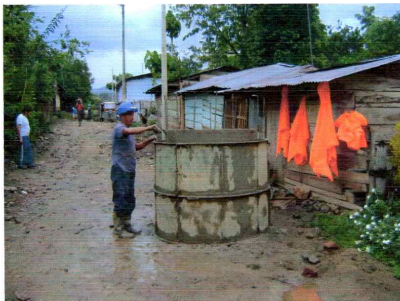
ENCOFRADO DE BUZON EN DIA LLUVIOSO
