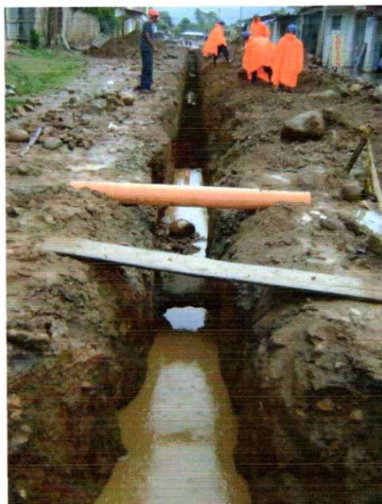
INSTALACION DE TUBERIA DE DESAGUE
