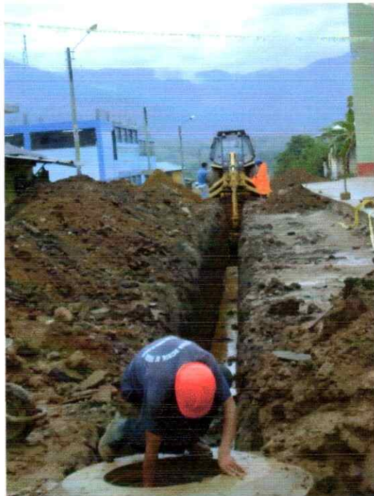
EXCAVACION DE ZANJA EN DIA LLUVIOSO
