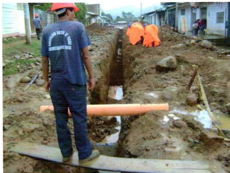
INSTALACION DE TUBERIA DE DESAGUE
