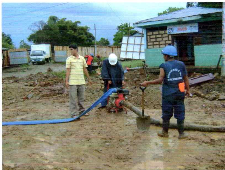
BOMBEO DE AGUA DESPUES DE LA LLUVIA
