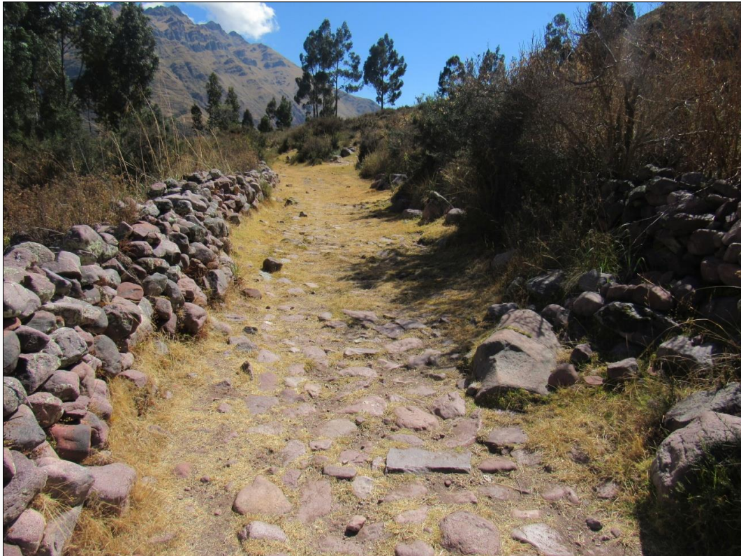
Vista del camino de tipo calzada empedrada
