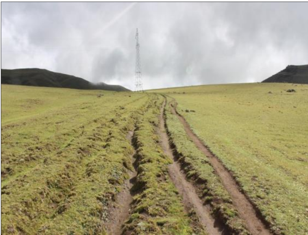
Vista panorámica de la construcción de torres de alta tensión, sobre la plataforma del camino.
