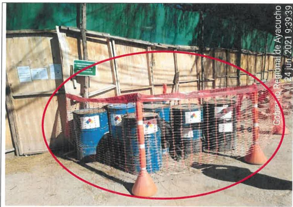
Almacenamiento temporal de Residuos Peligrosos sin las bandejas de contención y el techo respectivo
