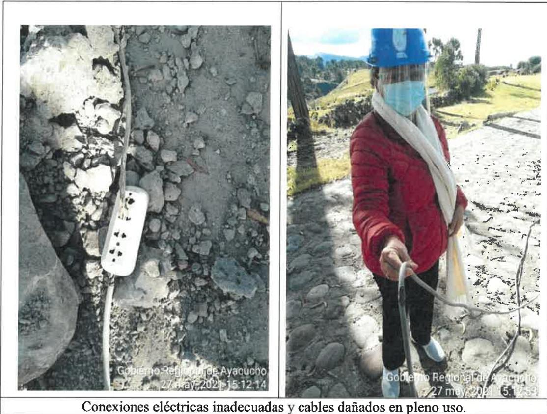
**Conexiones eléctricas inadecuadas y cables dañados en pleno uso.**
