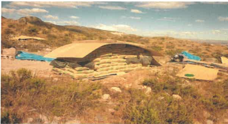
Inadecuado almacenamiento de cemento
