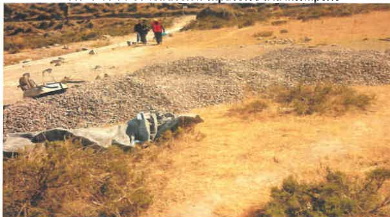
Inadecuado almacenamiento de agregados
