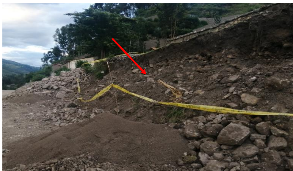
Fig. 5. Vista panorámica del perfil en el área supervisada, se observa la remoción del terreno en el lugar señalado.
