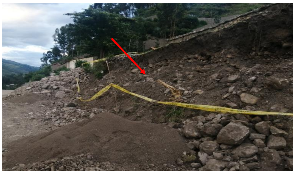
Fig. 2. Vista panorámica del perfil en el área supervisada, se observa la remoción del terreno en el lugar señalado.
