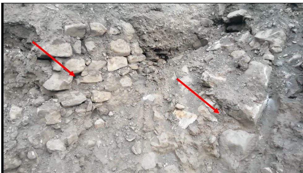
Fig. 6. Vista en detalle de los dos muros de contención que debieron formar dos plataformas en el lugar donde se ha realizado la remoción de terreno.
