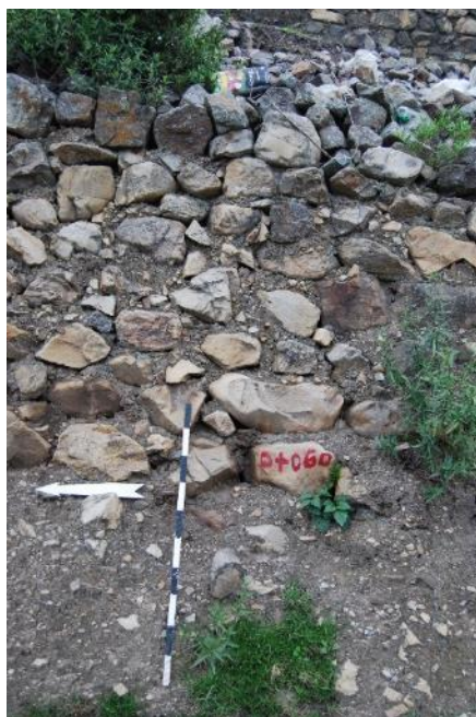
Fig. 3. Vista en detalle de la mampostería de área donde se realizaría la remoción de tierra. Nótese por la singularidad de la piedra y el uso de mortero de barro, al parecer se trata de la reutilización de una plataforma de origen prehispánico. Foto proporcionada por la Lic. Milagros Moreno Cotrína.
