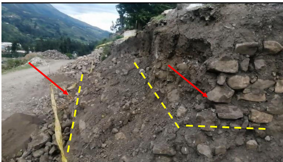
Fig. 8. Vista panorámica de uno de los muros de contención que debió conformar la plataforma en el área donde se ha generado la remoción de terreno.
