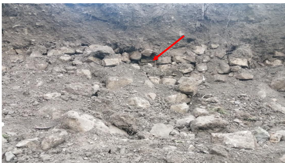
Fig. 7. Vista en detalle, se registra parte de un muro en el perfil del área donde se ha removido el terreno en el área supervisada.
