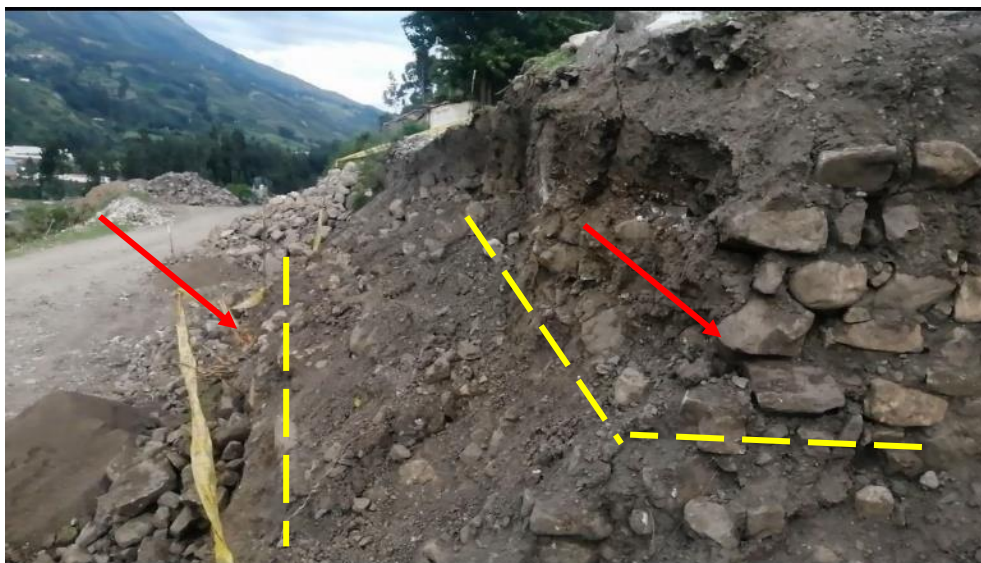
Fig. 5. Vista panorámica de uno de los muros de contención que debió conformar la plataforma en el área donde se ha generado la remoción de terreno.
