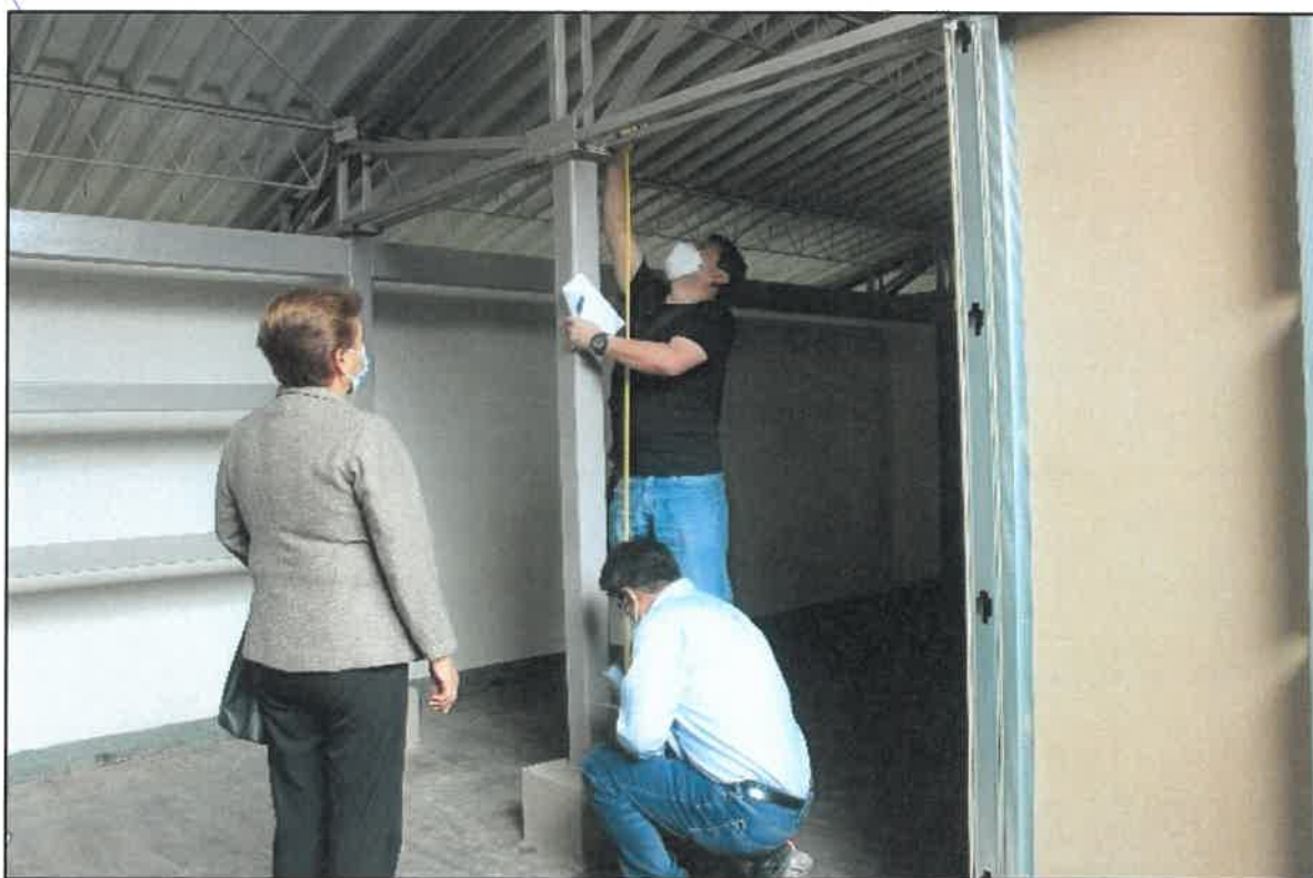
Las vigas se ubican a una altura de 2.15m del piso terminado
