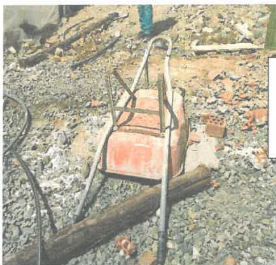
Vista fotográfica N° 18: Carretilla ubicada en el frontis del VAT del anexo de Pueblo Nuevo del distrito de Pullo de la provincia de Parinacochas, custodiada sin considerar daños externos (climatológicos) existiendo riesgo de pérdida y/o sustracción.
